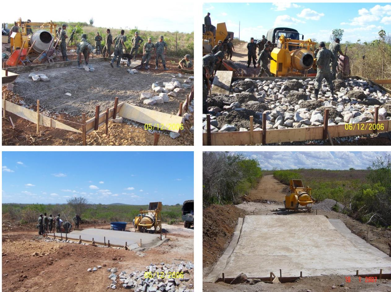
Figura 34 – Passagens molhadas construídas pelo 7º BE Cmb, em 2007.
