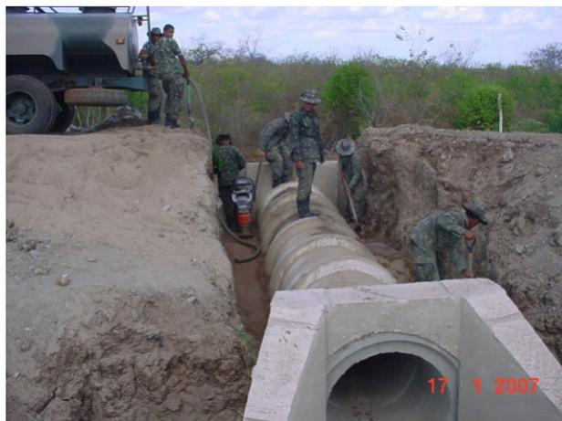
Figura 33 – Bueiros tubulares construídos pelo 7º BE Cmb, em 2007.
