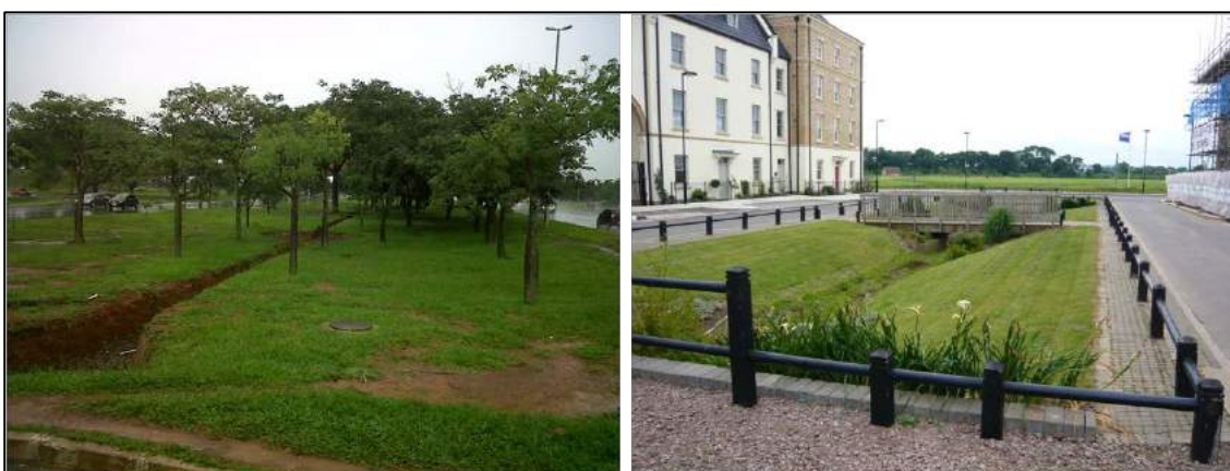
Figura 11 – Bacia de detenção /amortecimento.
